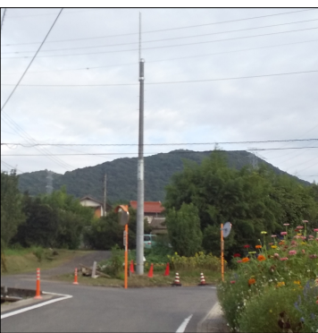
撤去予定のコンクリート柱
