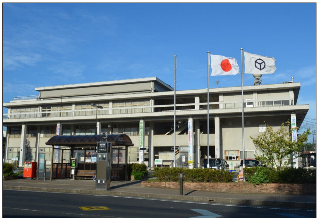
築後60年近く経過する松江市役所の本庁舎（松江市末次町）
