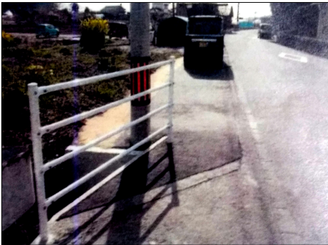
路肩整備前(上)と整備後(下)
