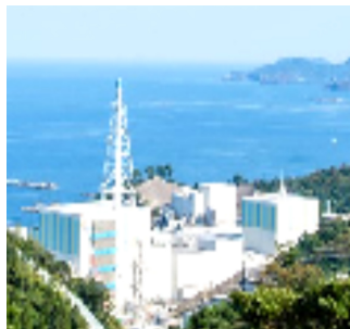
島根原子力発電所
