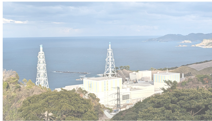
島根原子力発電所2号機
