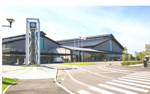
松江市総合体育館
